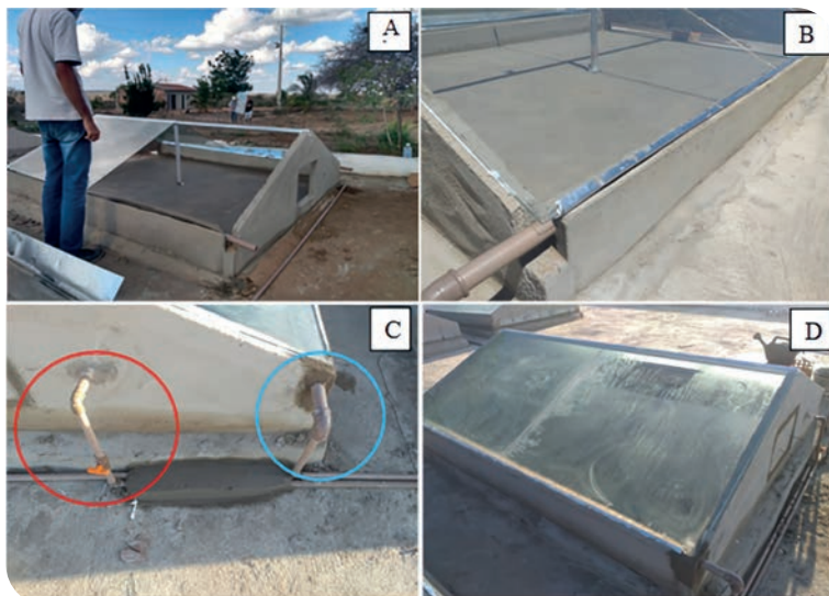
Figura 17. Montagem dos vidros (A) e (B); detalhe da entrada da água a ser tratada, abastecimento semiautomático (C), "circulo vermelho" e cano referente a saída da água dessalinizada, "circulo azul", água dessalinizada, tratada; dessalinizador com vidros em estado de condensação (D).
