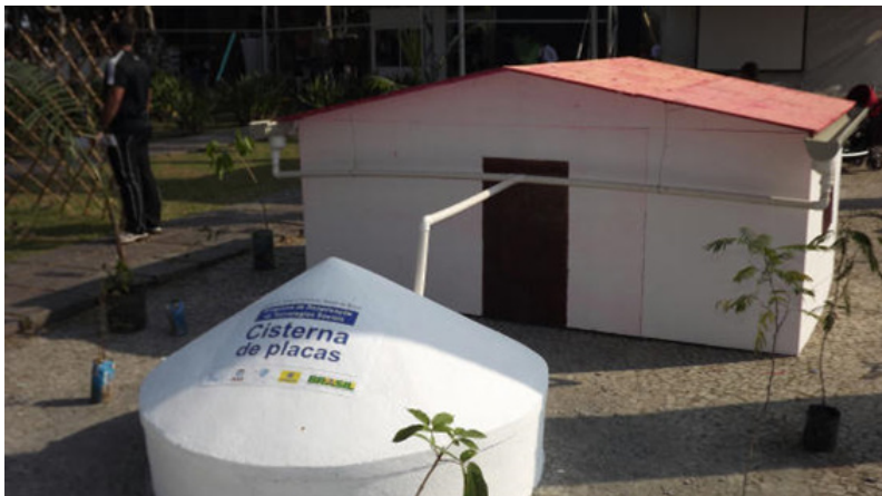
Figura 1: Estrutura da cisterna de placas de cimento, acoplada ao telhado de uma casa.
