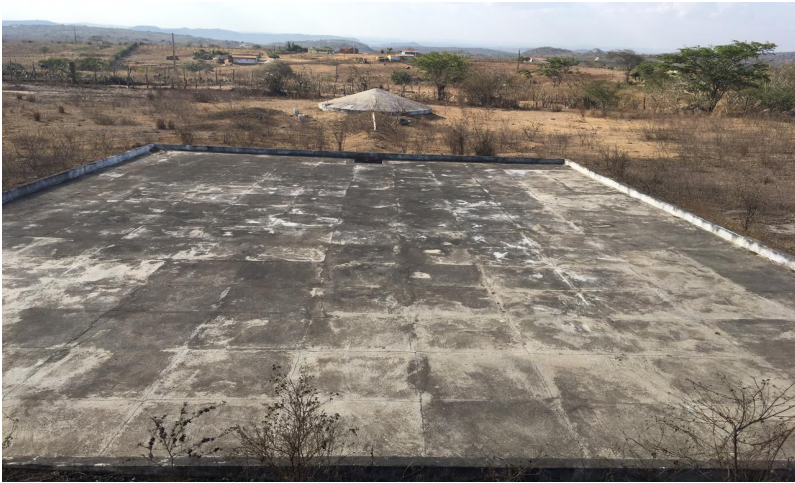
Figura 3 - Funil de coleta e decantação.
