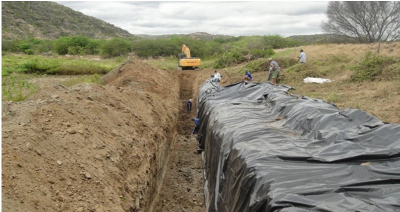
Figura 4: Construção de uma barragem subterrânea.
