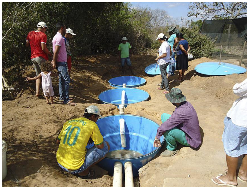
Figura 9. Esquema de montagem de uma fossa séptica padrão Embrapa.
