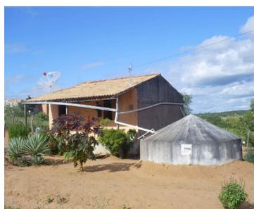
**Figuras 4 e 5** – Cisterna cilíndrica de placas pré-moldadas de cimento acoplada ao sistema de captação de água de chuva no Assentamento Cajueiro e Mocambo, respectivamente
