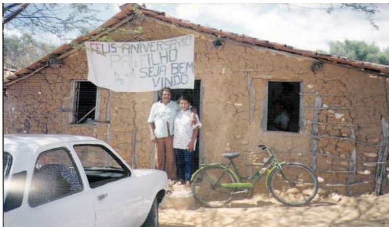
Figura 6 - Aspectos da construção das casas no Talhado
