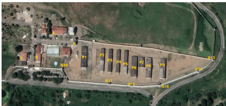
Figura 1 - Visão aérea do Presídio Raimundo Asfora - Serrotão. Imagem alterada com legendas para identificação
