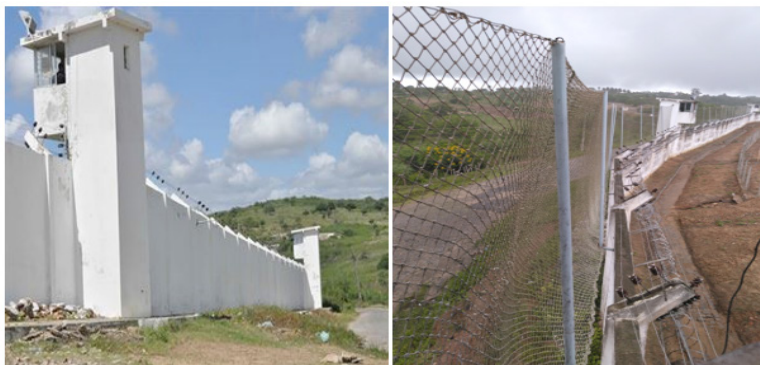
Figura 5 - Presídio do Serrotão antes e depois da colocação de tela de contenção
