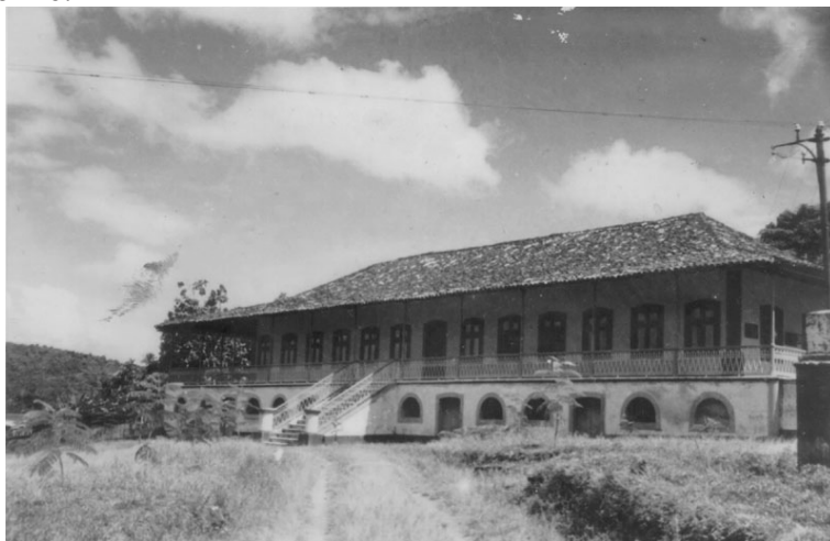
FOTO 8 – Casa-Grande do Engenho Sapucagi, Escada-PE
