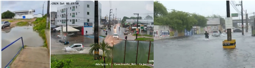
Figura 14 – Pontos de alagamento no bairro do Geisel
