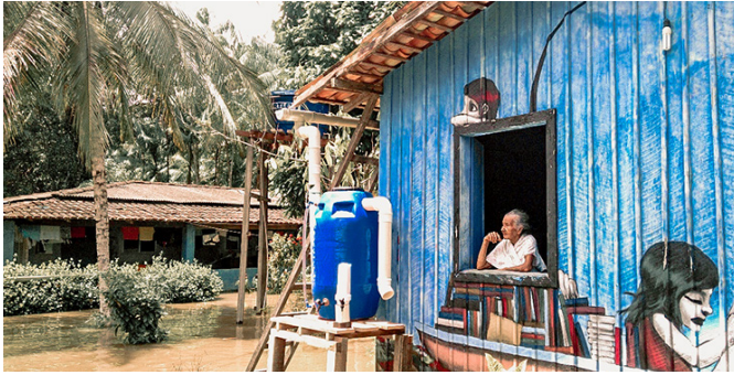
Figura 6 – Uma das cisternas instaladas na casa de uma moradora ribeirinha
