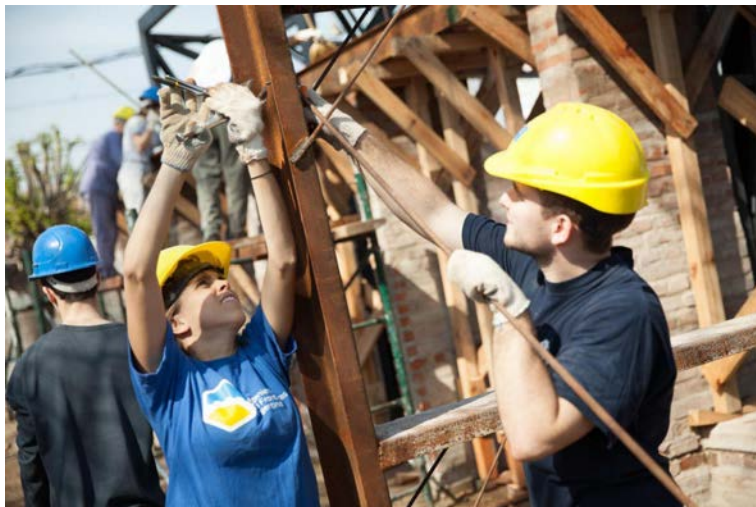
Fotografía 3: Voluntarios y voluntarias en obra de ISF-Ar
