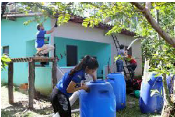
Figura 5 – Estudantes instalando as cisternas em uma casa de comunidade ribeirinha
