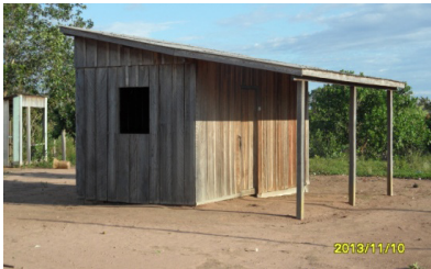
Figura 3 – Habitação de madeira em aldeia Nambikwara, Comodoro, MT.
