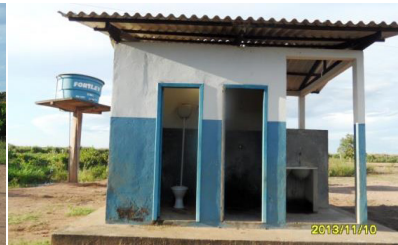
Figura 4 – Módulo Sanitário para os Nambikuara, Comodoro, MT.
