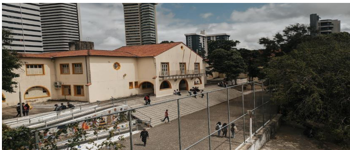
Figura 1: Edificação da ECIT. DR Elpídio de Almeida
