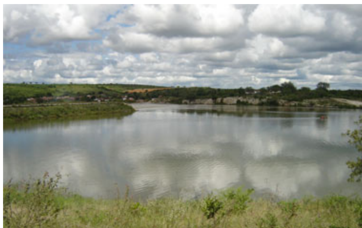
Açude Epitácio Pessoa - Boqueirão. Vista do sangradouro principal (2009)
