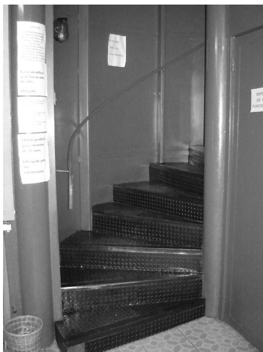
Foto 14 – A. Vinholes – Escada de acesso ao mezanino
