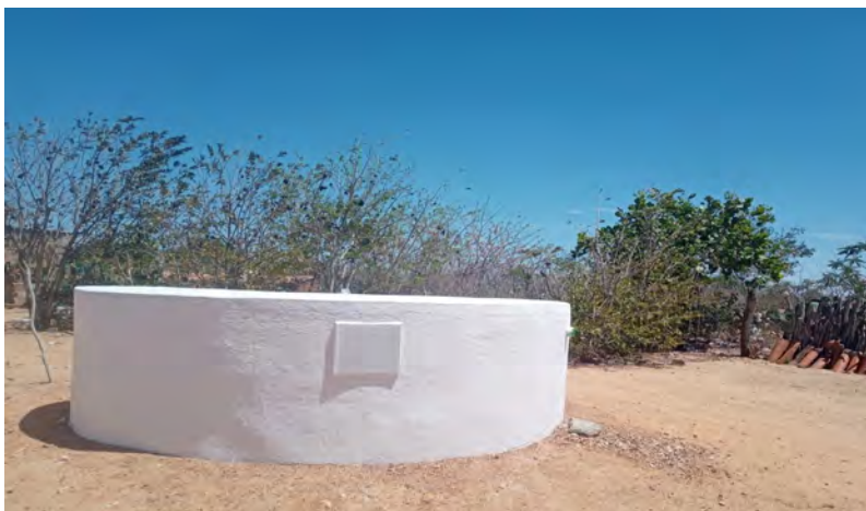
Figura 1 - Cisterna de Placa de 16.000 L implantada no semiárido paraibano Fonte: Rede Água-PB.
