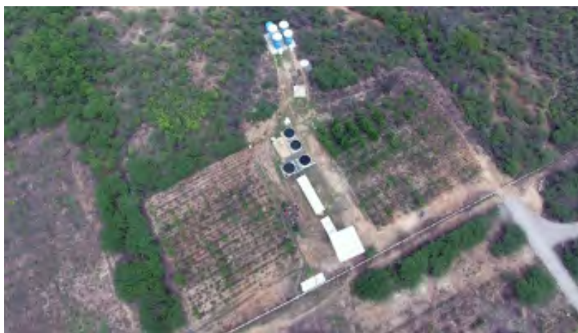
Figura 16 - Visão panorâmica do sistema de tratamento de esgoto e unidades experimentais de reúso agrícola Fonte: Arquivo de propriedade do INSA (Foto: Felipe Lavorato).
