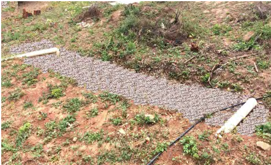
Figura 10 - Vista superior da vala de infiltração Fonte: Arquivo dos pesquisadores (2021).
