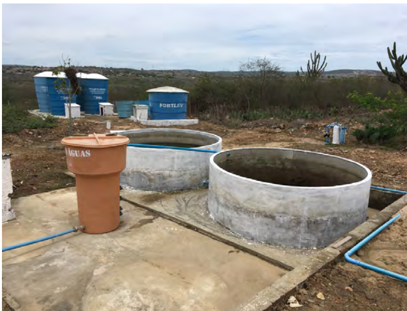
Figura 13 - Reator UASB utilizado no experimento Fonte: Arquivo de propriedade do INSA (Foto: Mateus Mayer).
