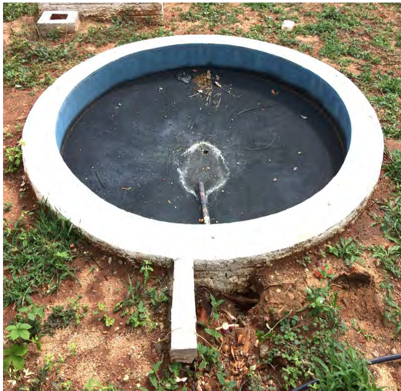
Figura 9 - Vista superior do reator solar Fonte: Arquivo dos pesquisadores (2021).
