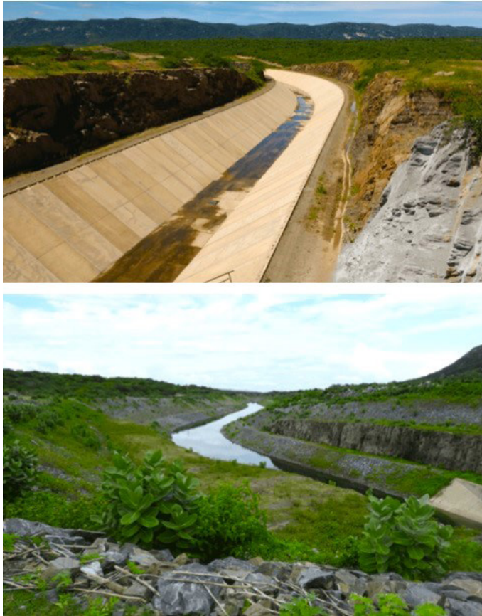
Figura 24 – Canais abertos da transposição do rio São Francisco
