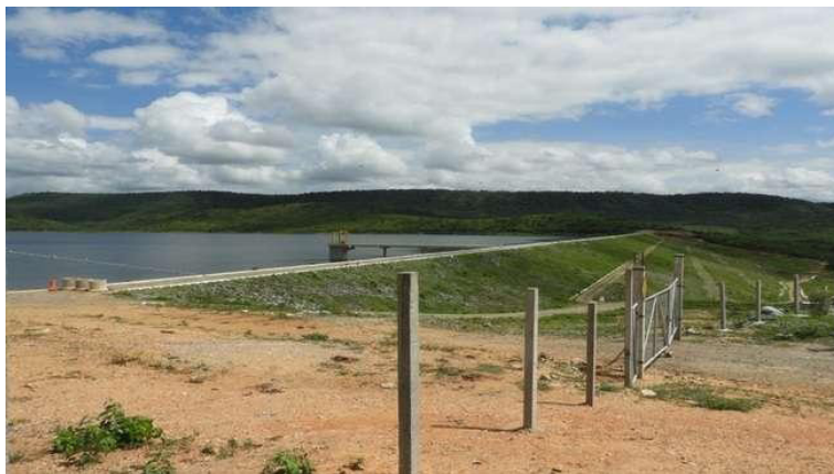
Figura 25 – Barragem Boa Vista
