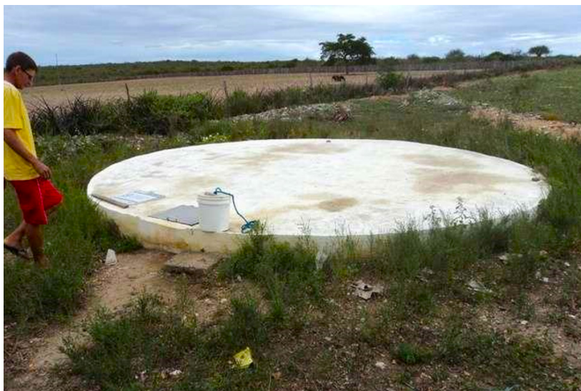
Figura 5 – Balde com corda para retirar água da cisterna
