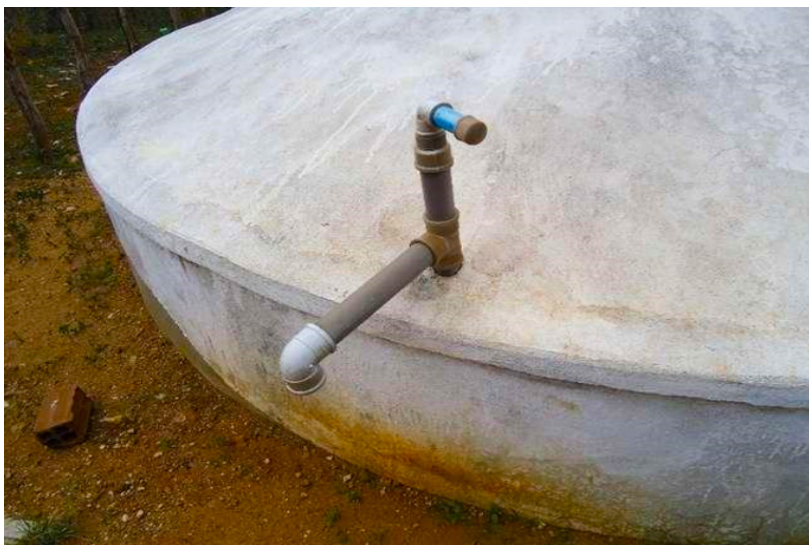
Figura 4 – Cisterna com bomba manual
