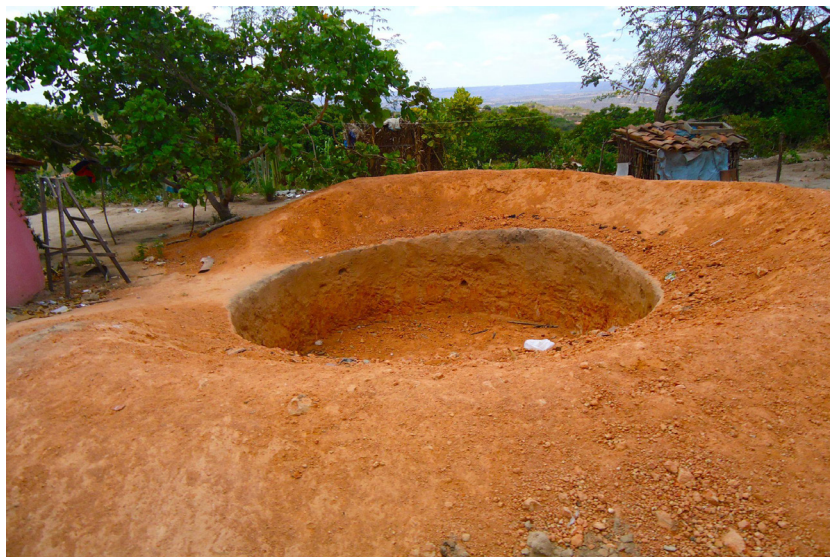
Figura 2 – Local onde foi feita a escavação para a construção da cisterna
