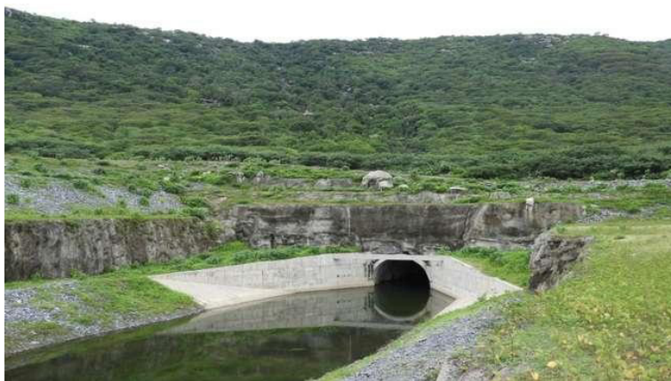
Figura 23 – Túnel Cuncas I
