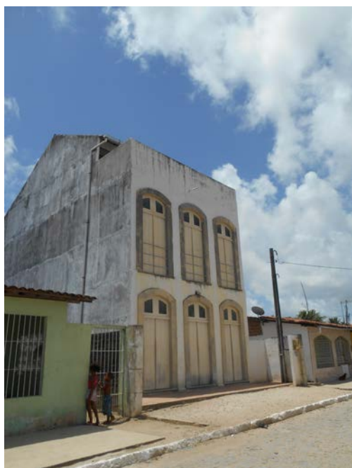
Foto 10 - Prédio do CVT (Centro Vocacional Tecnológico), construído pelas mulheres da Associação de Marisqueiras da comunidade de São Lourenço, que foi usado como espaço de formação do SENAI para a costura de bancos de couro, de onde foram contratadas operárias para a Lear, sistemista do Polo Automotivo da FCA. Atualmente o prédio abriga o grupo de artesãs “Quilombolas de São Lourenço”, formado por exclusivamente por mulheres. Foto: Mario Henrique Ladosky
