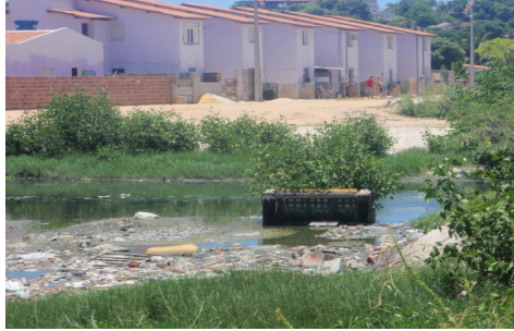
Figura 6 - Conjunto habitacional V8, seu esgoto tem interligação ao Canal da Malária, que não tem manutenção aparente. Os resíduos ficam bem visíveis Fonte: Harlam Vieira, 2016.
