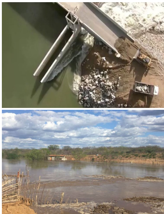
Figura 1 – Rompimento da barragem
